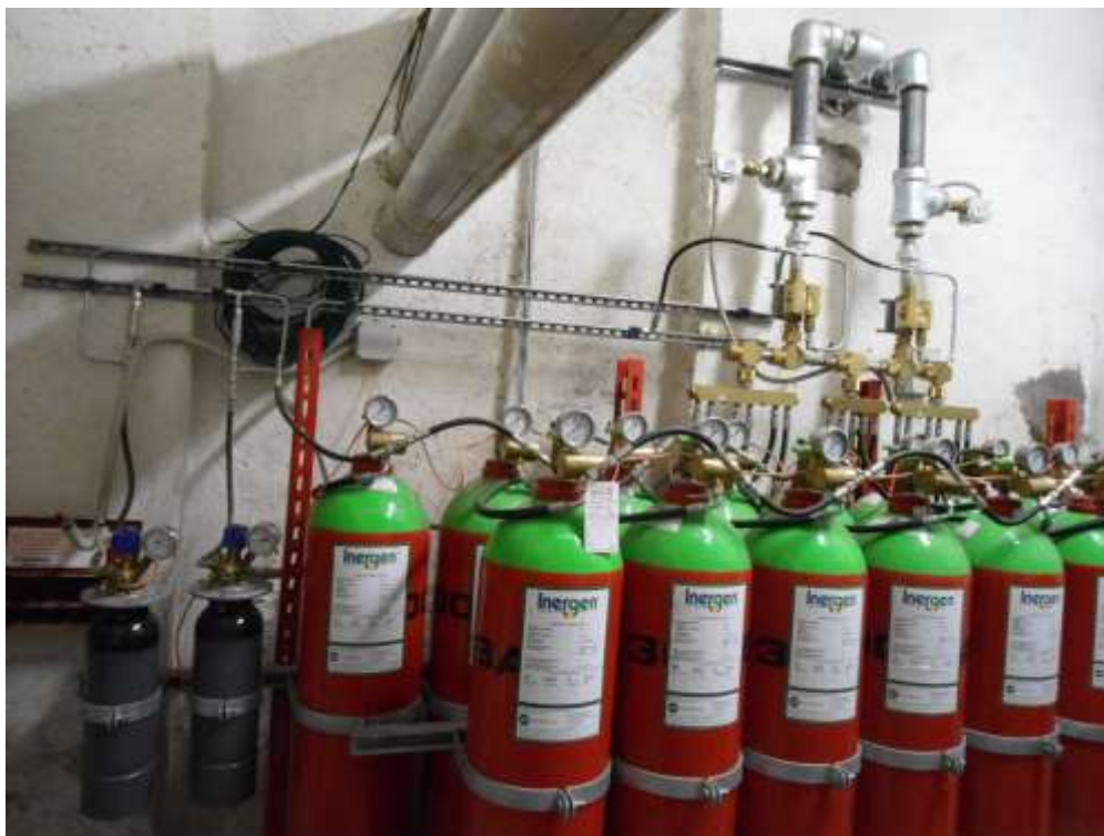
gruppo con valvola direzionale e attuatore pneumatico
